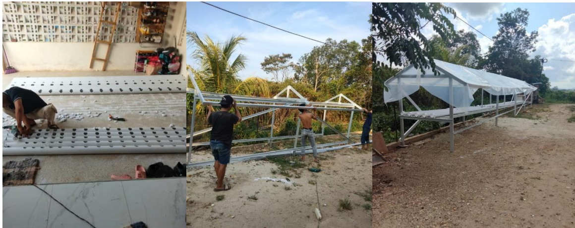
Gambar 3. Pemasangan Media Tanam
